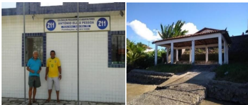
FIGURA 2 - FACHADA E ESTALEIRO COLÔNIA Z-11.
