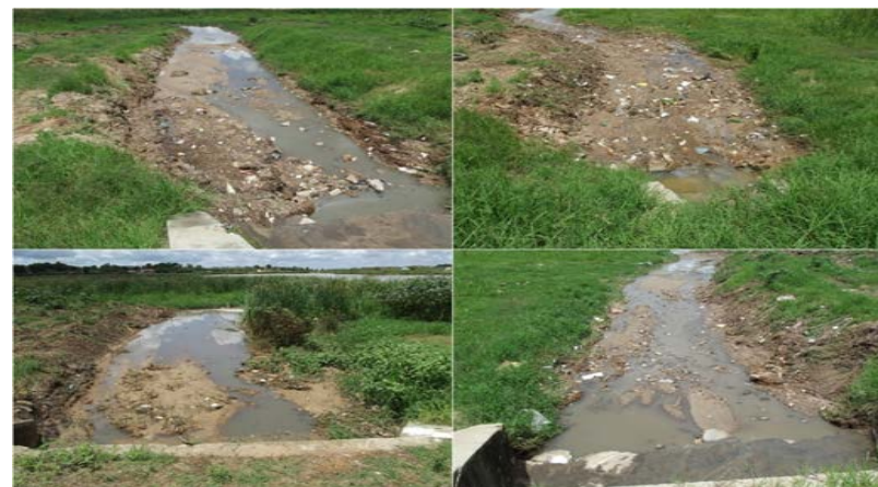
FIGURA 9. VISTAS DA ENTRADA PRINCIPAL DE ÁGUA NA LAGOA
