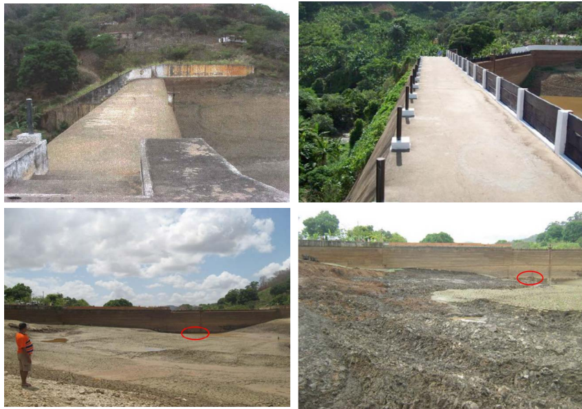
a) Barragem sem stop-log . Fonte: CAGECE, 1999; b) Barragem com stop-log após reforma de 2009. Fonte: COGERH, 2009; c) Vista de montante da barragem antes da limpeza da bacia hidráulica. Fonte: COGERH, 2009; d) Vista de montante da barragem após a limpeza. Fonte: COGERH, 2009.
