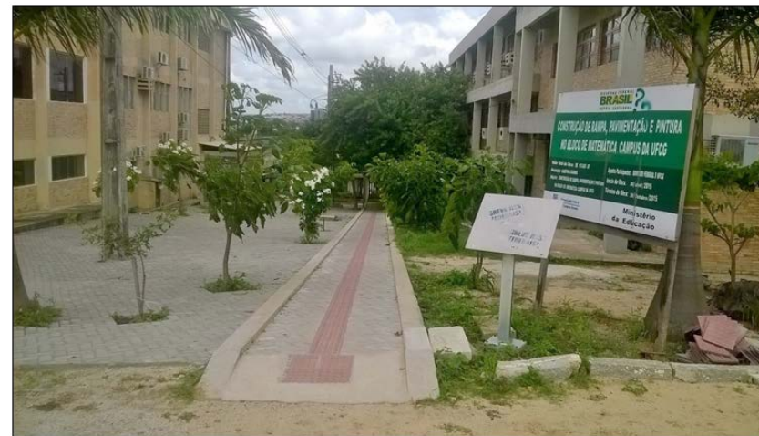
IMAGEM 02: PASSARELA DE ACESSO COM PISO TÁTIL DIRECIONAL E DE ALERTA.
