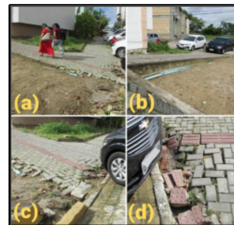
Ilustração 29–Acesso do Bloco BG com a presença de calçada rebaixada
