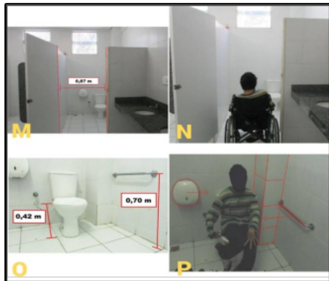
Ilustração 44–Banheiro acessível do Bloco BG (térreo)
