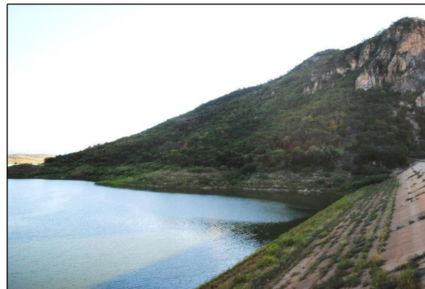
Figura 3 - Açude Engenheiro Ávidos na barragem em Cajazeiras
