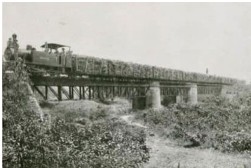
Figura 3 - A ferrovia da Usina João Alfredo (c.1910)
