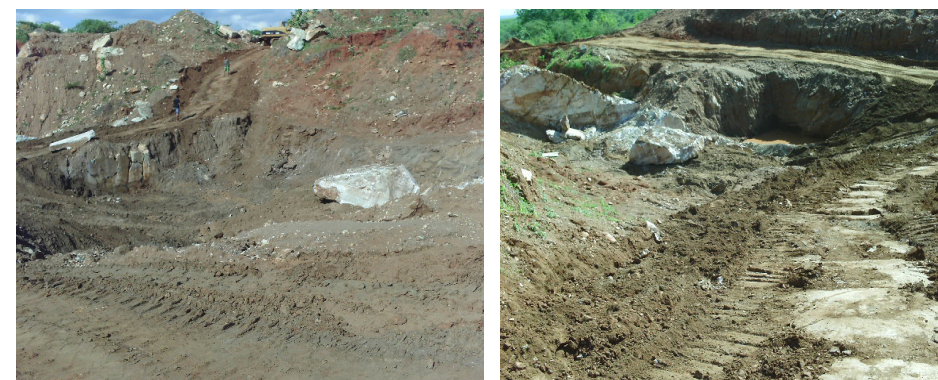
Figura 5 – Descapeamento ou desbravamento do local para extração. Fonte: Própria – Visita in loco , 2011.
