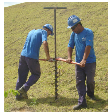
FIGURA 01- (A) TRADO MANUAL; (B) TRADO MECÂNICO
