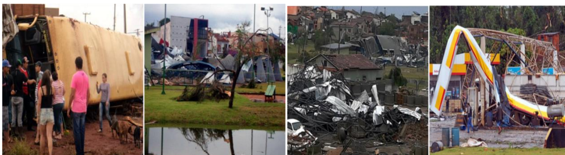
Figura 1. Danos causados pelo tornado na cidade de Taquarituba/SP, em 22/09/2013.
