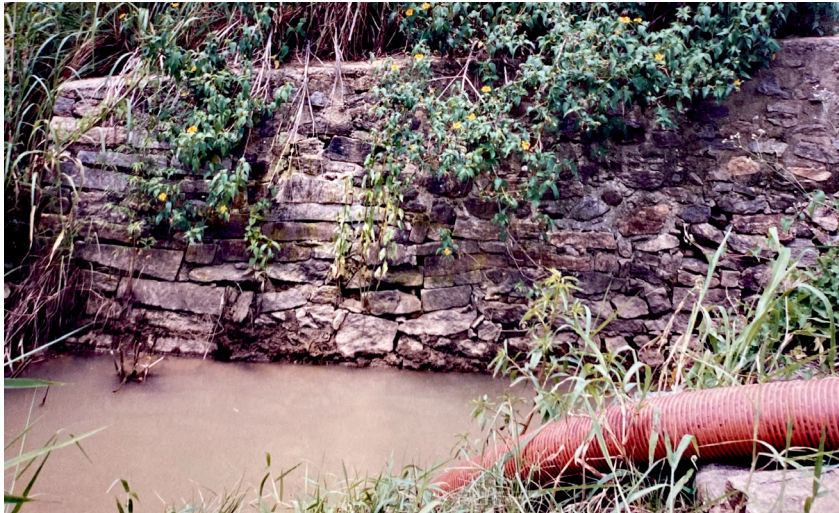
FOTOGRAFIA 05 – RESERVATÓRIO DE ÁGUA DA ÉPOCA DA CRC.
