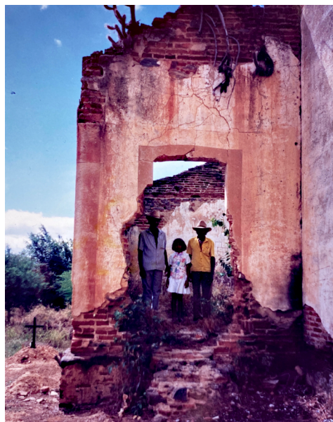
FOTOGRAFIA 09 – PORTAL, ENTRADA LATERAL DAS RUÍNAS DA IGREJA.
