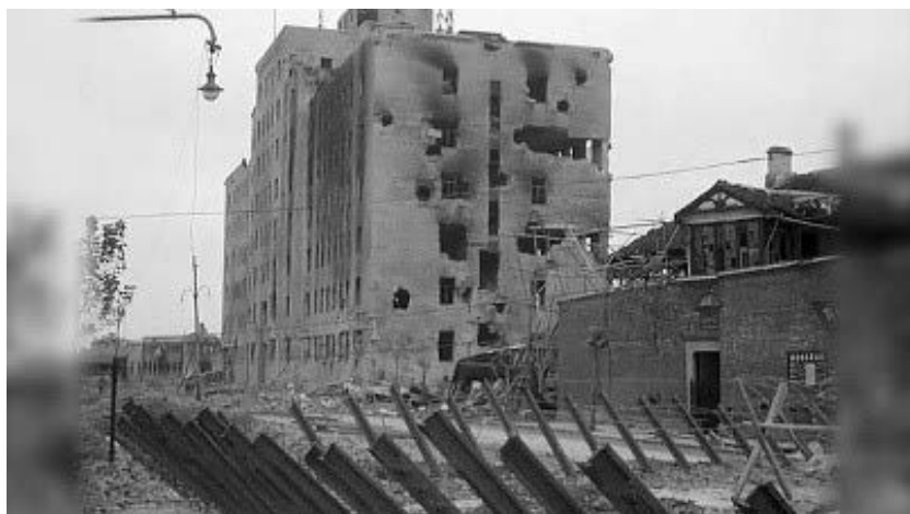
FIGURA 28 – SHANGHAI, 1937: EDIFÍCIOS BOMBARDEADOS POR AVIÕES JAPONESES.
