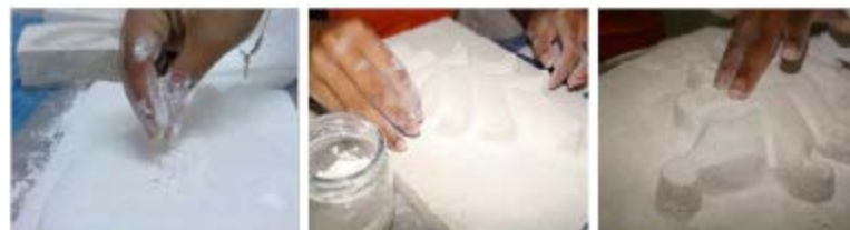
FIGURA 16 – APLICAÇÃO DE CAULIM SOBRE OS MOLDES DE CONCRETO CELULAR
