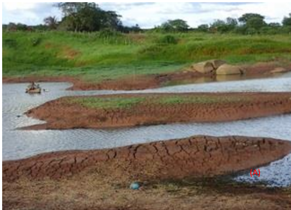
Figura 3– Assoreamento no açude Jatobá II (A), volume de água (B)
