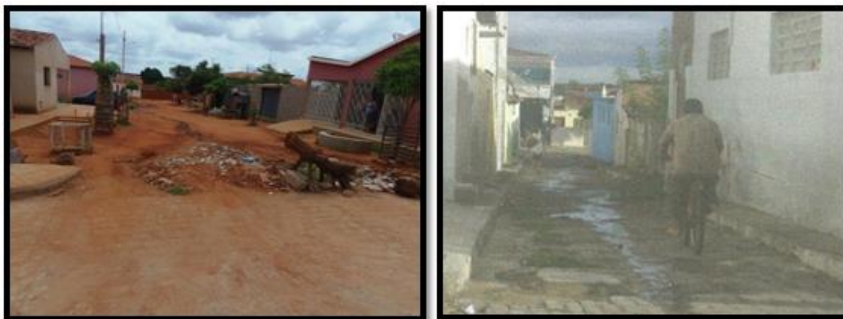
Figura 5- Erosão das ruas formando canais de drenagem do solo no centro da cidade
