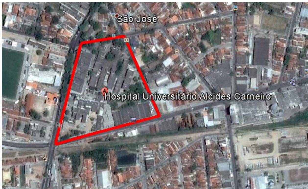
Figura 1– Vista aérea do Hospital Universitário Alcides Carneiro
