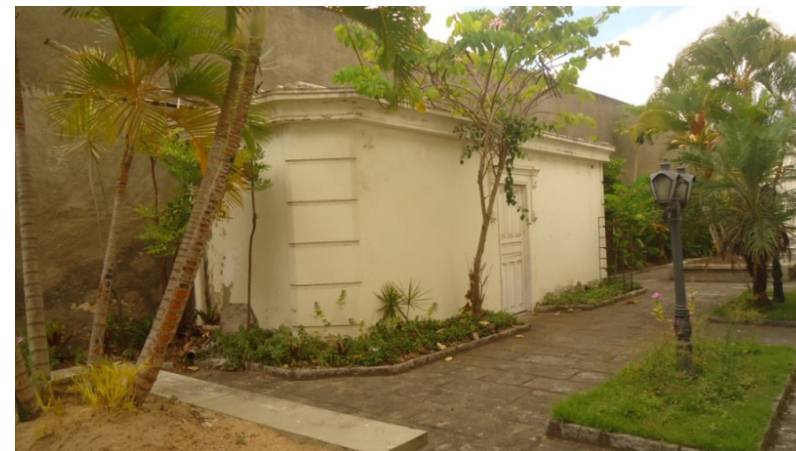
FIGURA 3: ESTRUTURA QUE SERVIU DE BANHEIRO PARA O GRUPO ESCOLAR SOLON DE LUCENA NO JARDIM, LOCALIZADO AO LADO DIREITO DO PRÉDIO
