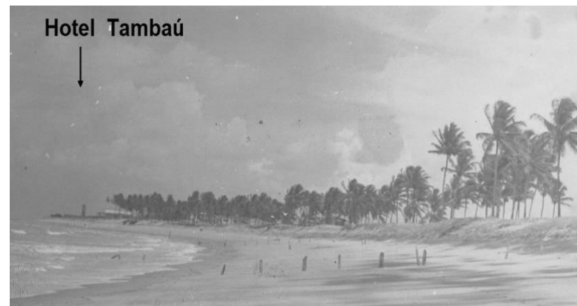
FIGURA 4 —VISTA DA PORÇÃO SUL DA ENSEADA DE MANAÍRA COM O HOTEL TAMBAÚ LOGO APÓS SUA CONSTRUÇÃO, OU SEJA, MEADOS DE 1972.
