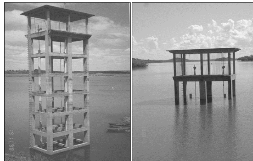
FOTO 1 – VISTAS DA TORRE DE TOMADA DE ÁGUA (2015) E (2004).
