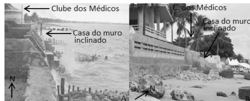
FIGURA 6 – PRAIA DO BESSA, TRECHO AO NORTE DA CASA DE REPOUSO
