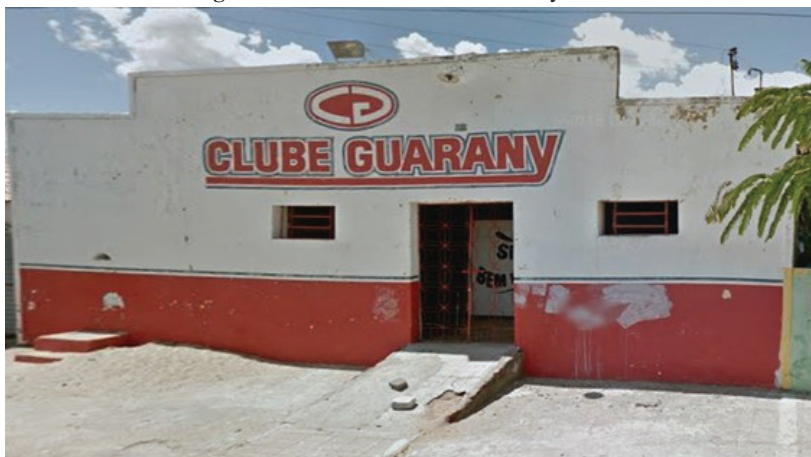
Fotografia 1: Fachada do clube Guarany em 2012.
